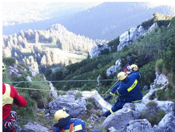
Oben: Wegewart über den Wolken Unten: Die Sprenggruppe des THW Miesbach bohrt am Schafsteig Löcher für die Sprengladungen
